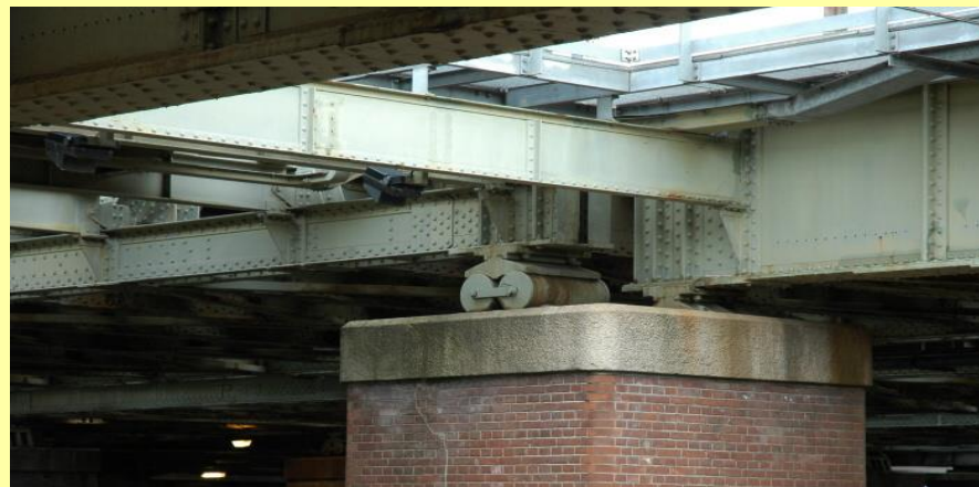
Obr. 9.26 Teplotná rozťažnosť (Serway, 2006), (Reichel, 2010).
